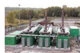
⑭ Victoria 1/2, Lünen Victoria-Gas Anzahl Module: 3 x 1.36 kW
